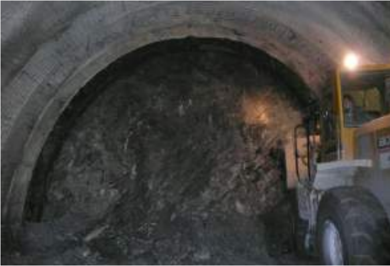
Şekil 3. Dallıkavak Tüneli çelik içs yerleştirilmesi
