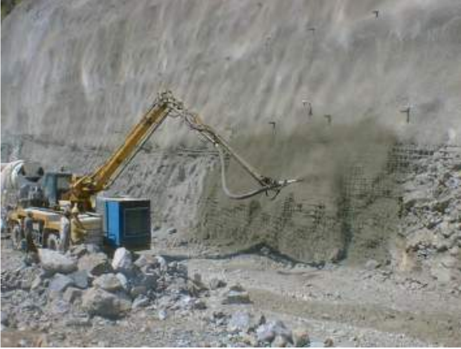
Şekil 4. Dallıkavak Tüneli portal desteklemesi
