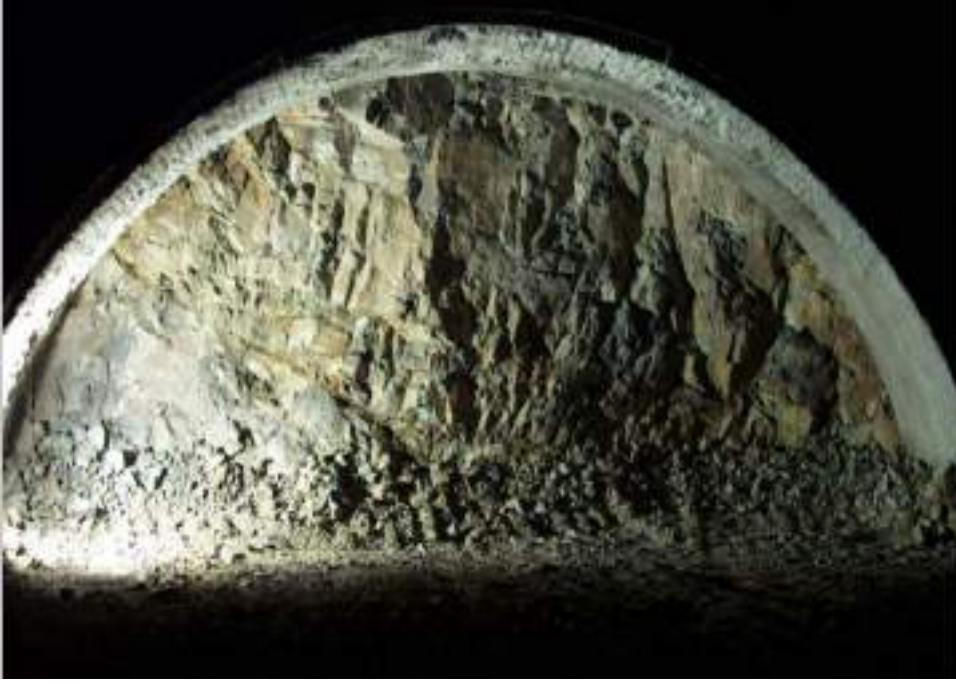
Şekil 6. Dallıkavak Tüneli üstyarı kazı kesiti
